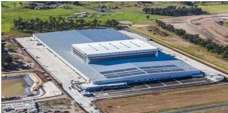
IKEA MLFU Rooftop PV Project
